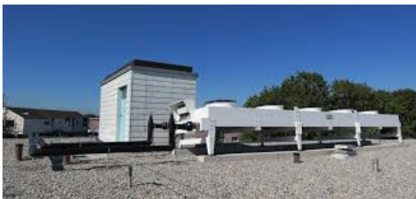
Luft/Sole-Wärmeübertrager auf dem Dach mit Sole-Zwischenkreis und Wärmepumpe im Keller
