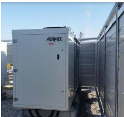
Luft/Wasser-Wärmepumpe auf dem Dach
