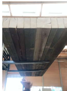
Mock-Up Brettstapeldecke roh / gehobelt
