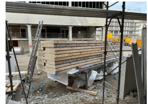
Mine: Brettschichtholz von temporärem Pavillon des Formel-E- Rennens Bern 2019
