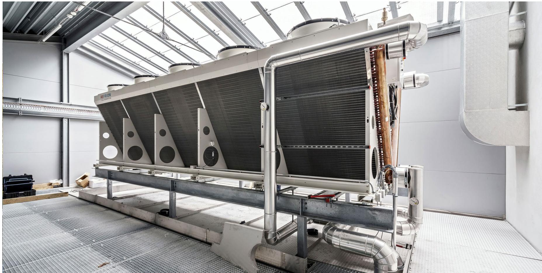
**Wärme und Kälte mit strombetriebenen, reversiblen Luft-Wasser-Wärmepumpen.**
